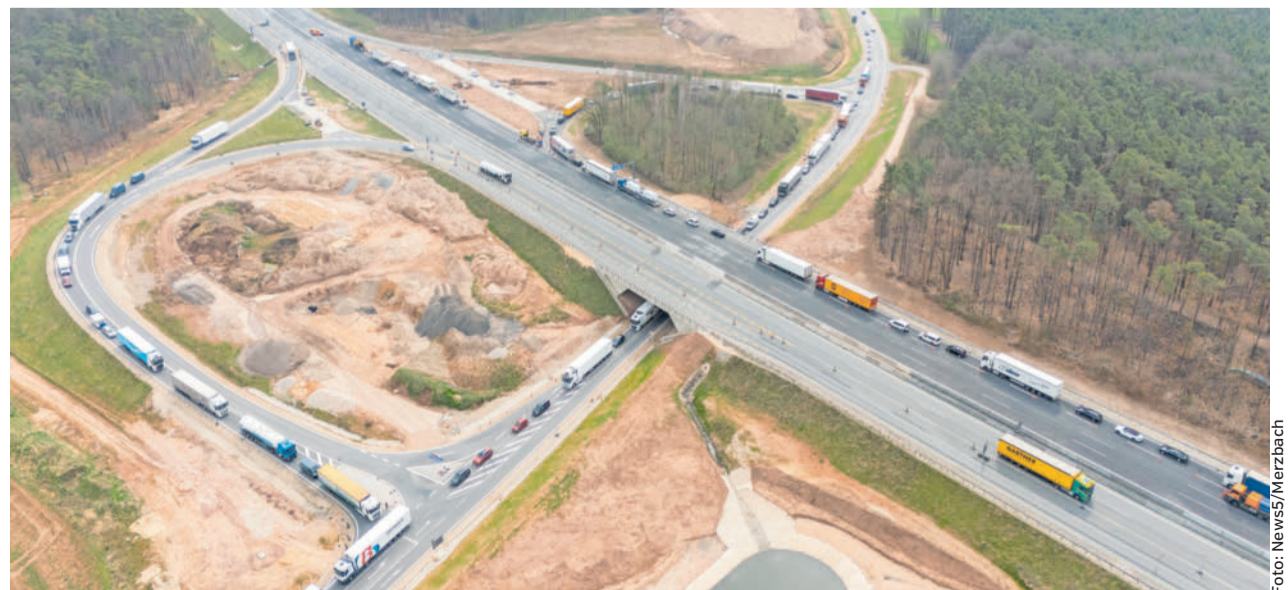
Wegen des Schadens ist die A3 bei Höchststadt komplett gesperrt.
